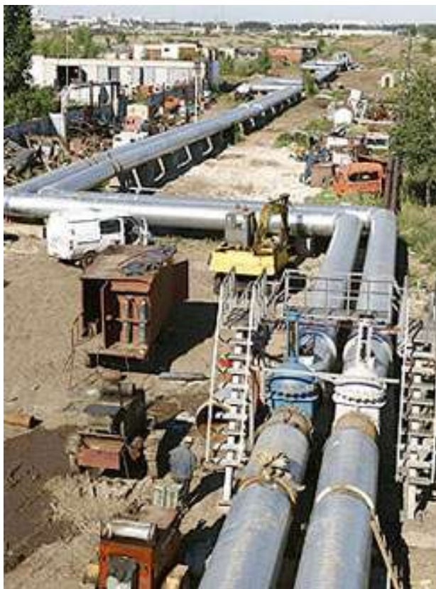
Рис. 32. Присоединение новых потребителей к тепловой сети
