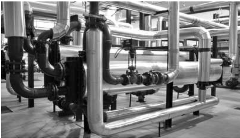
Рис. 5. Центральный тепловой пункт (ЦТП)
