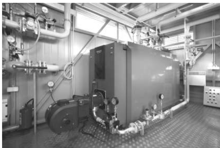
Рис. 8. Водогрейный котел
