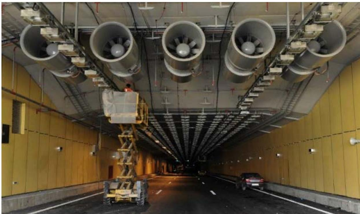
Рис. 19. Осевые вентиляторы в автодорожном тоннеле
