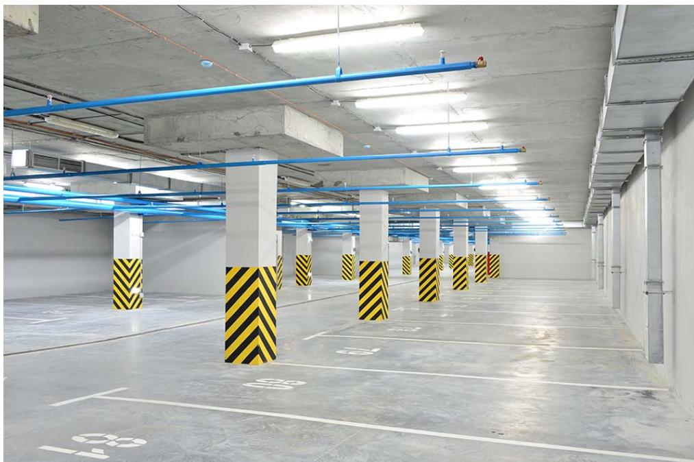
Рис. 22. Установки автоматического пожаротушения на подземной автостоянке
