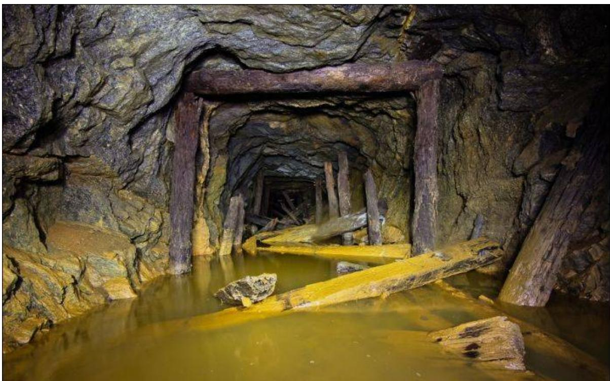
Рис. 3. Затопление горной выработки
